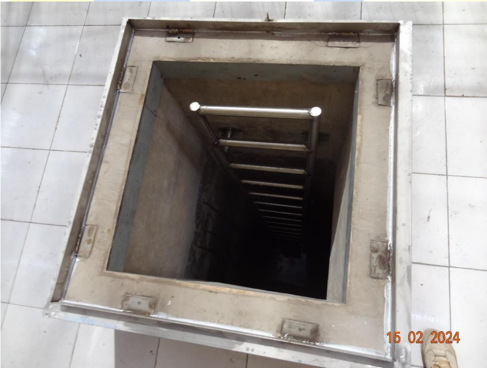
Recuperación Escotillas, tapas y escala sala Bombas}
